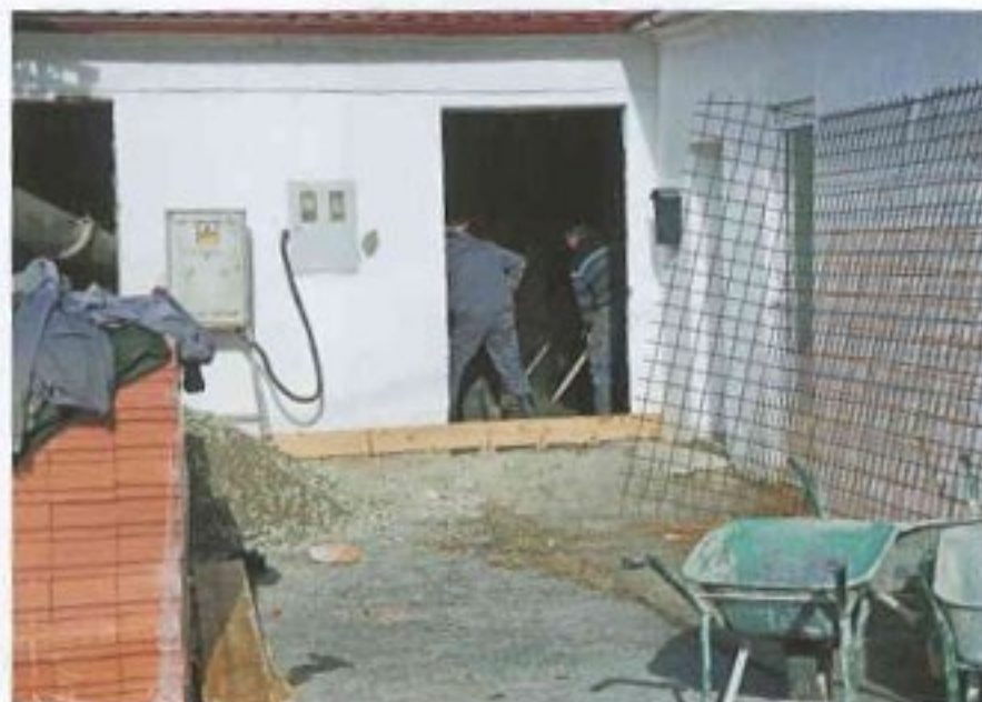
Rekonštrukcia kultúrneho domu
