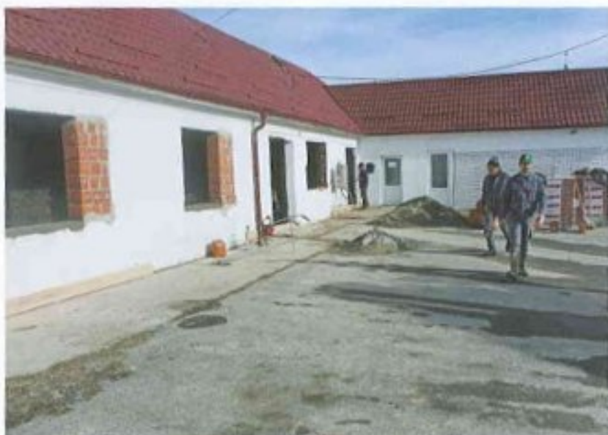
Rekonštrukcia kultúrneho domu
