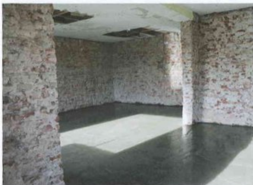
Rekonštrukcia kultúrneho domu
