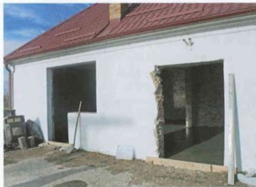
Rekonštrukcia kultúrneho domu
